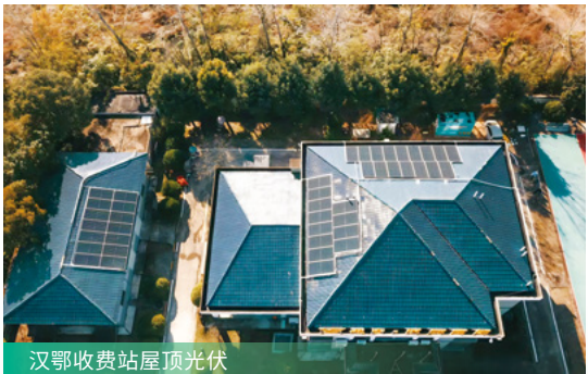
汉鄂收费站屋顶光伏
