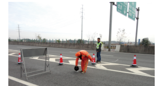
道路安全养护
